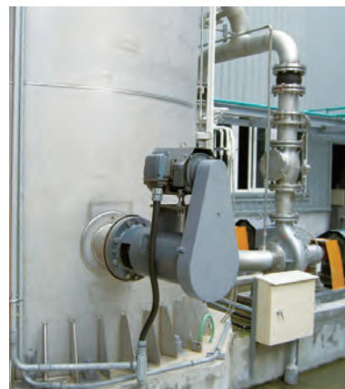
側插桶槽(單卡夾+格蘭軸封)
